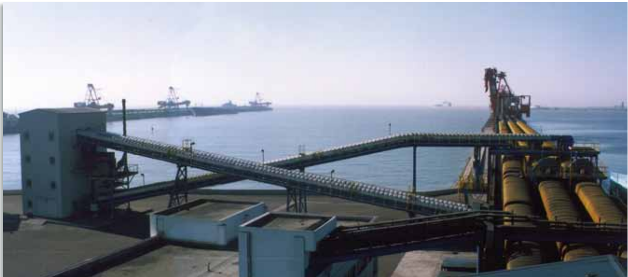
Probenahmeanlage für Kohle, Schiffsverladung in Quinhuangdao, China
