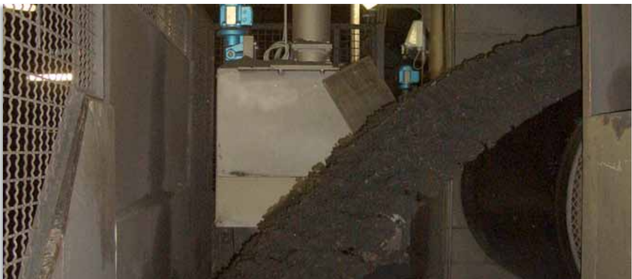
Probenehmer im Materialstrom
